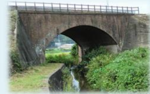
② 国道3号側から見たアーチ橋と清流。向こうは村山田。
